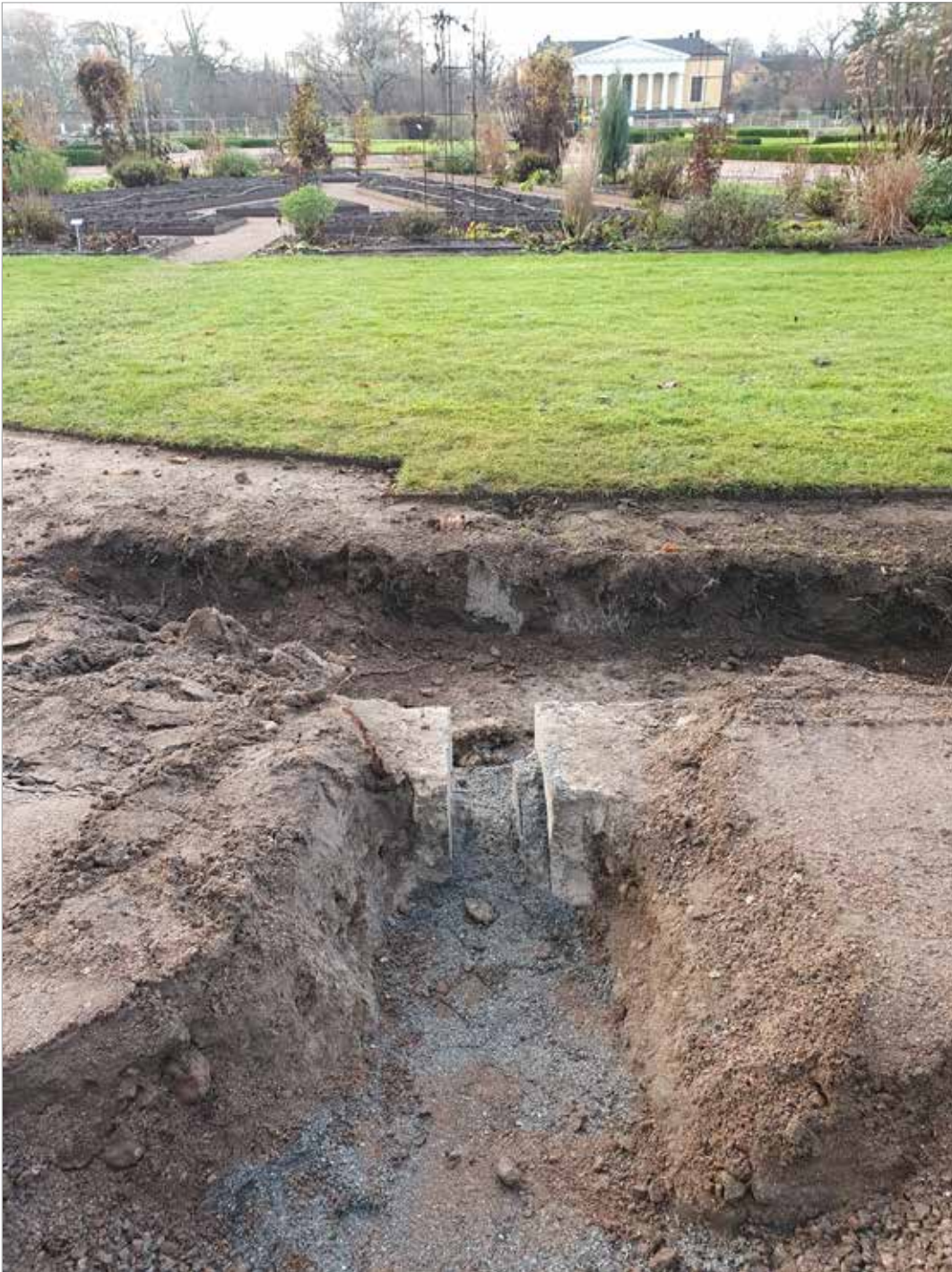
Betongmuren under mark i områdets sydöstra del kapades för att inte hindra bevattningssystemet. Foto Stina Kajtorp 2022-11-30.
