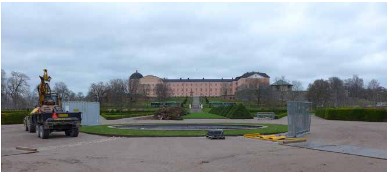
Rivning pågår av gransolitärerna i den norra mittraden. Körplåtar har lagts ut som skydd över de båda stensatta rännorna Helge å och Motala ström som troligen anlades under 1840-talet. Foto 2022-11-11.
